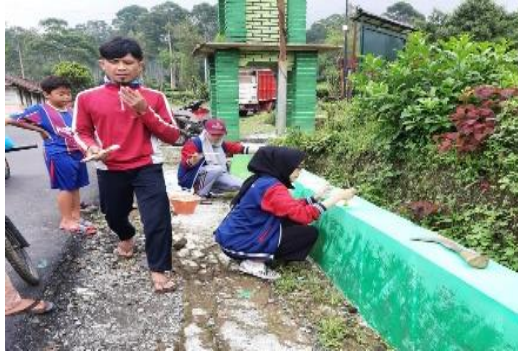
Gambar 4. Program pengecatan tembok pembatas jalan desa
