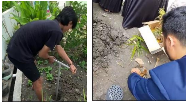
Gambar 7. Proses Pembuatan Lubang dan Memasukkan Pipa PVC Beserta Sampah Organik Pada Lubang Resapan Biopori
