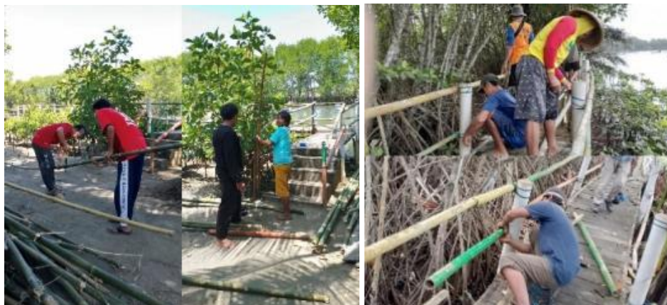
Gambar 6. Perbaikan Area Jembatan atau Tracking
