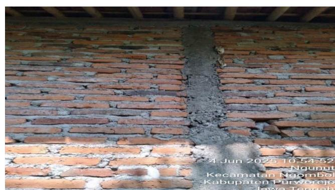
**Gambar 5.** Bangunan Dengan Kondisi Kolom Keropos
