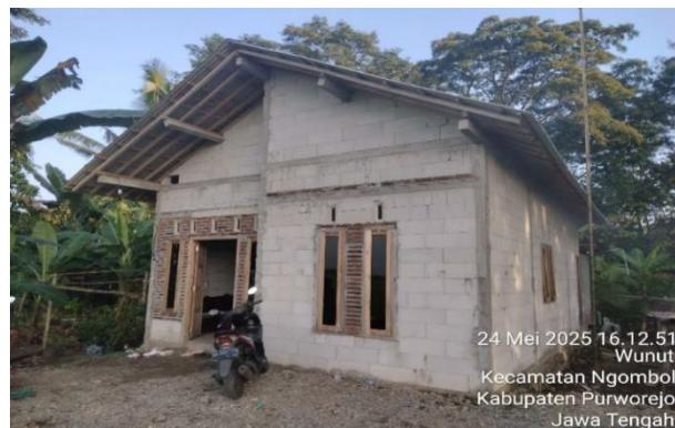
Gambar 6. Bangunan Tanpa Ring Balok Miring/Ampig
