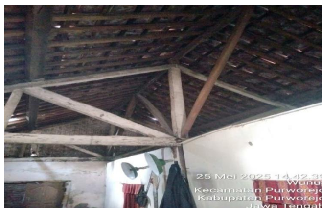
Gambar 7. Kuda-kuda Tanpa Plat Baja
